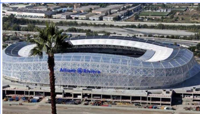
Nice – Allianz Riviera – Capacité 35 000 places Club Résident OGC Nice 200 Barres de précontrainte \phi 36 pour Ancrage de la Charpente
