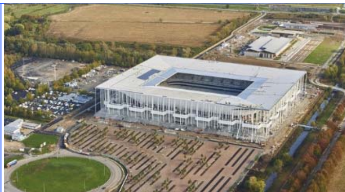
Bordeaux – Nouveau Stade – Capacité 42 000 places Club résident Girondins de Bordeaux Appareils d'appui ETIBLOC Néoprène Fretté & 8 Amortisseurs pour Protection au Vent
