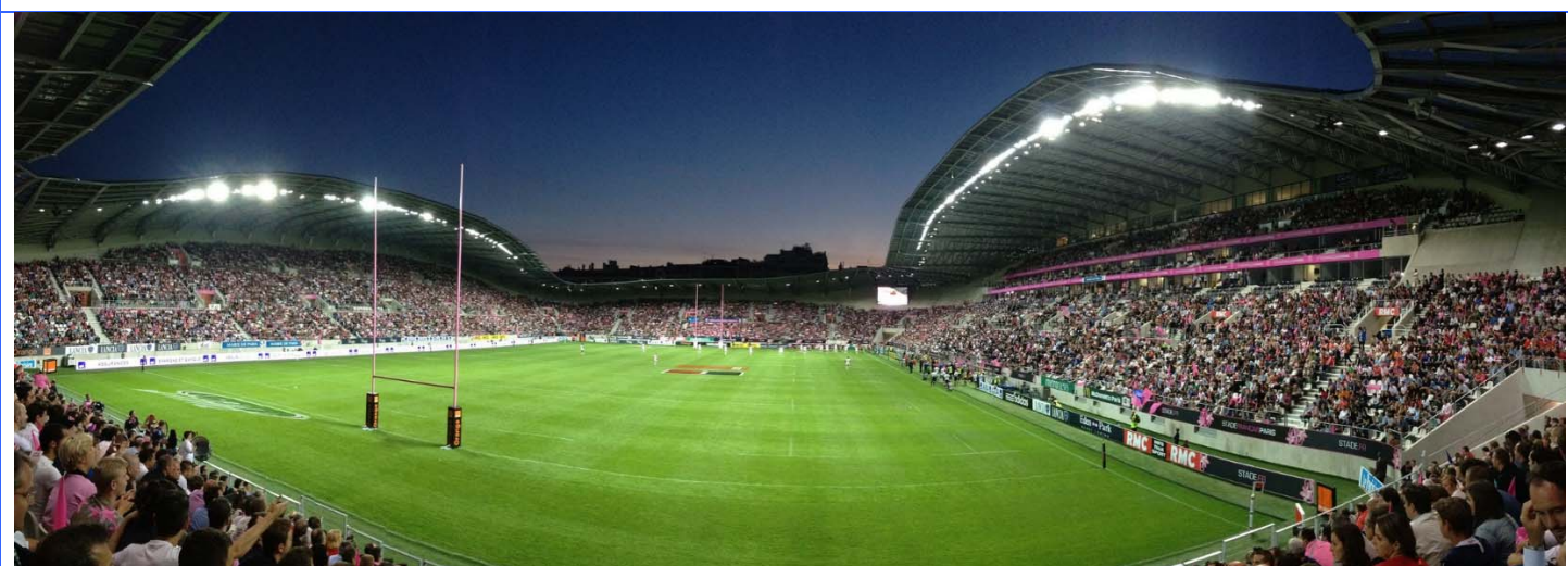
Paris – Stade Jean Bouin – Capacité 20 000 places Club Résident Stade Français Précontrainte par post-tension de 11 poutres
