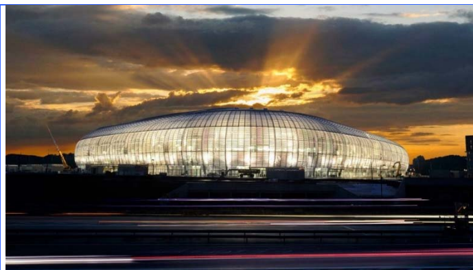
Lille – Stade Pierre Mauroy – Capacité 50 300 places Club résident LOSC 4 appuis Sphériques 31500 kN sous les mégapoutres du toit coulissant
