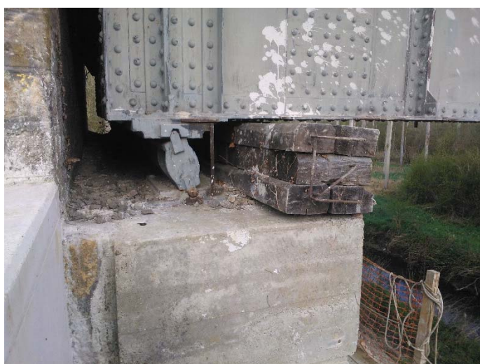
Appareils d'appui métalliques et calage de sécurité existants
