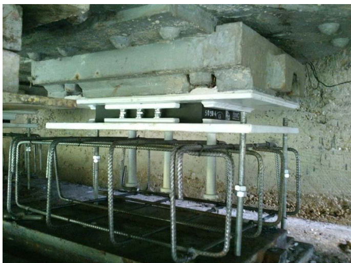
Appareil d'appui ETIBLOC multidirectionnel avec ses platines et taquets anticheminement
