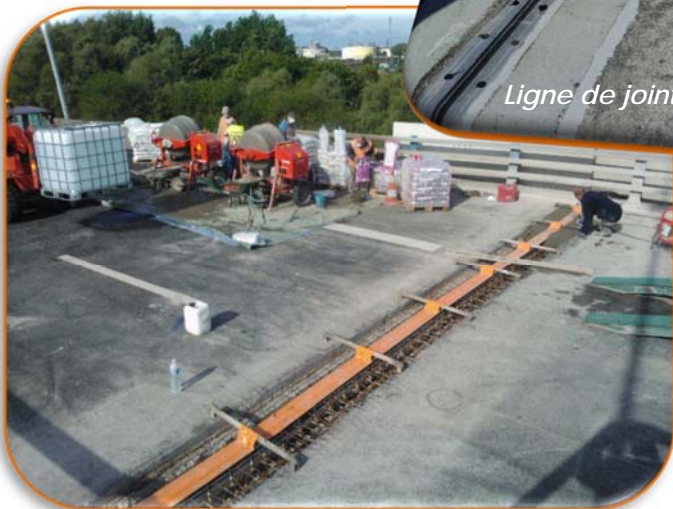
Joint réglé en cours de bétonnage
