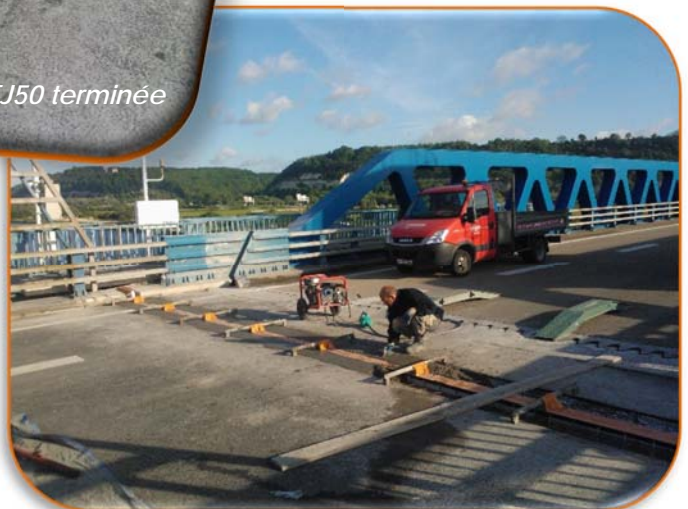
Bétonnage du joint
