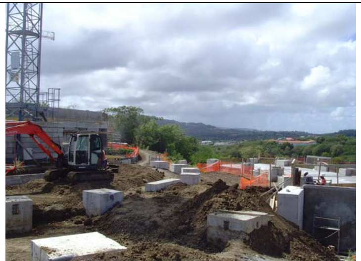
Vue Générale de l'infrastructure avec Massif Isolateur
