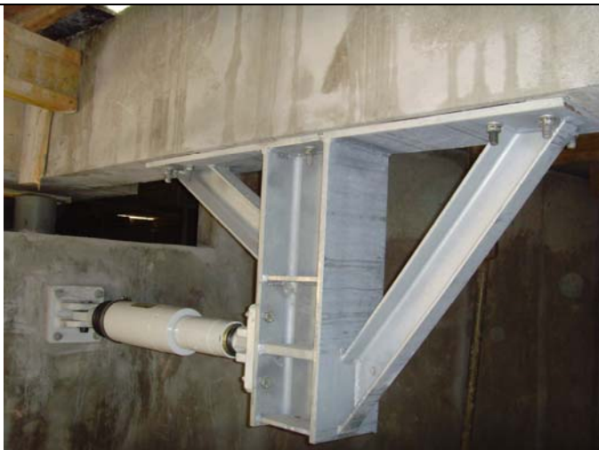
Amortisseurs sur massif avec Isolateurs
