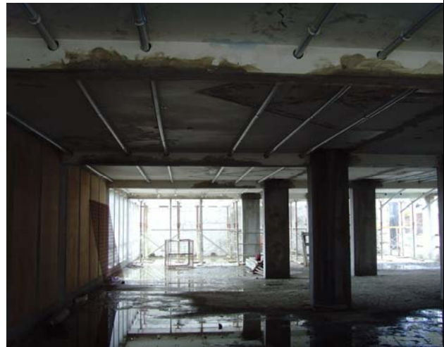
Diffusion des efforts en extrémité de dalle sur structure additionnelle -Additional concrete structure at each extremity of the cables Elevation du Bâtiment – Building elevation
