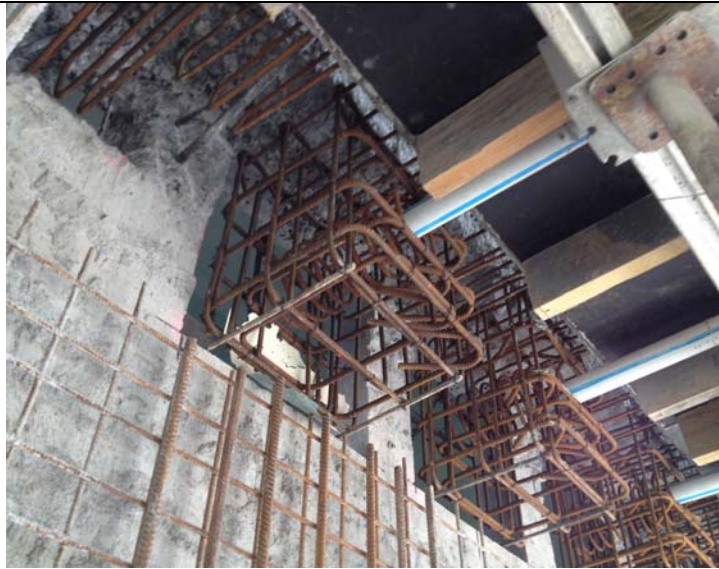
Diffusion des efforts en extrémité de dalle sur structure additionnelle -Additional concrete structure at each extremity of the cables Elevation du Bâtiment – Building elevation
