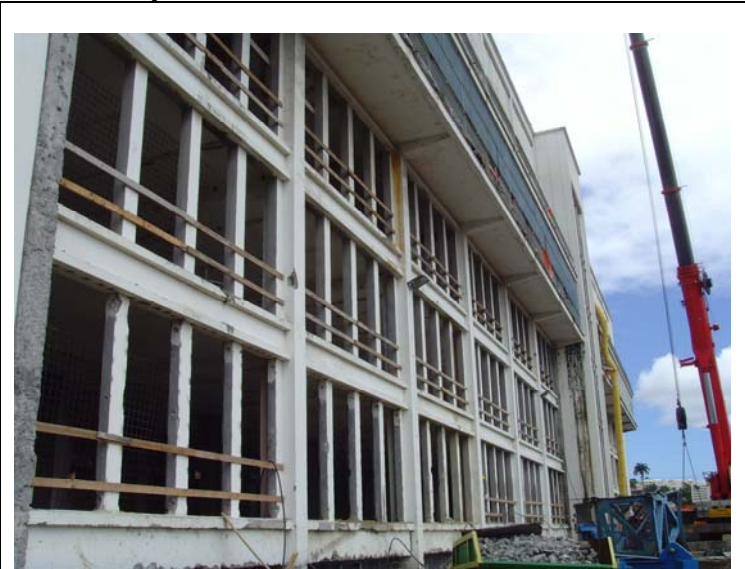
Diffusion des efforts en extrémité de dalle sur structure additionnelle -Additional concrete structure at each extremity of the cables Elevation du Bâtiment – Building elevation
