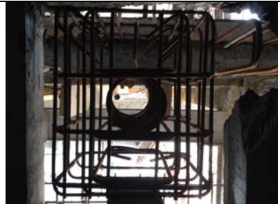
Diffusion des efforts en extrémité de dalle sur structure additionnelle -Additional concrete structure at each extremity of the cables Elevation du Bâtiment – Building elevation
