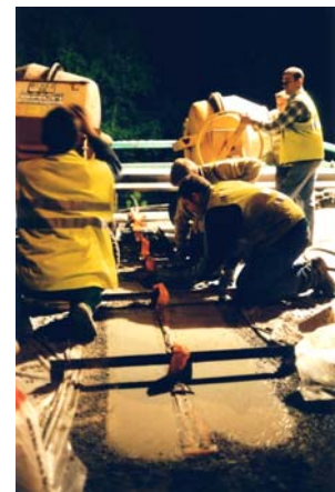
mise en œuvre du BETEC DSP 343 à prise rapide
