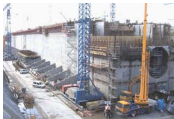
← vue générale du chantier
