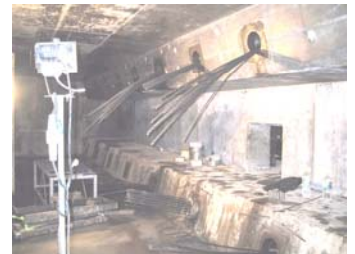
→ vue intérieure du caisson
