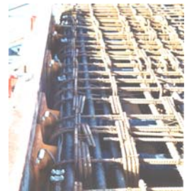
→ trompettes et plaques d'ancrage
