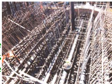
→ trompettes et plaques d'ancrage
