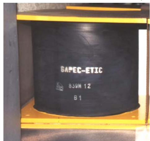
↓ Isolateur avec n° identification
